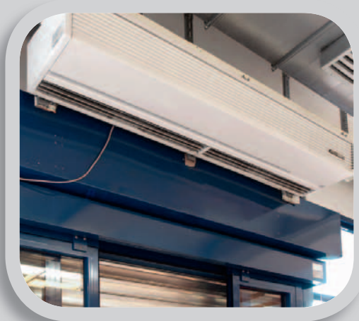
Obr. 1 Tradiční a těžkopádná vzduchová clona namontovaná odděleně od pohonu dveří
